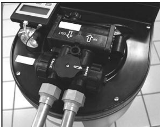
Рис.5. Байпасный кран на фильтре
