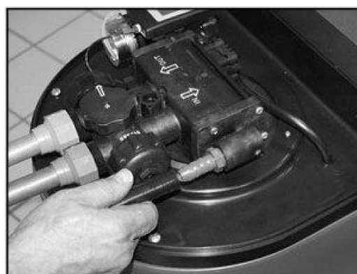
Рис. 3. Подсоединение дренажной линии
